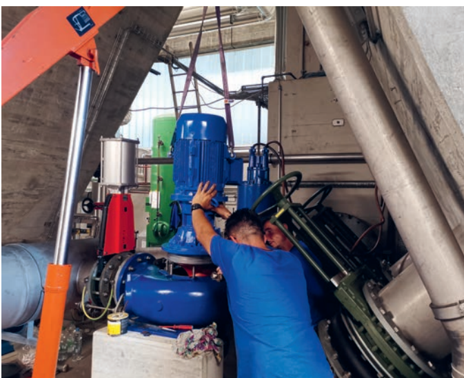
Mit vereinten Kräften werden die neuen Pumpen präzise montiert.
