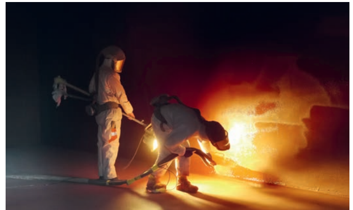
Die spezielle Beschichtung wird von Hand auf dem Boden ...
