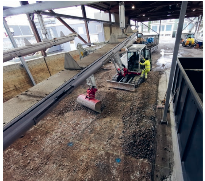
Die Fundamente müssen während des laufenden Betriebs ausgehoben werden.
