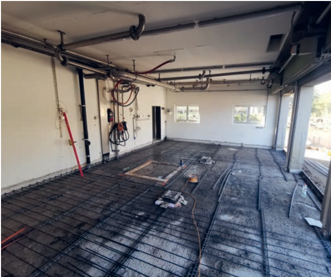
Die Armierung sowie die Sanitär- und die Elektrorohre sind verlegt.
