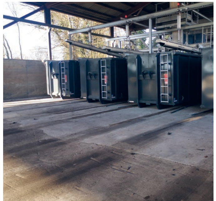
Alle Stahlplatten sind verankert und bündig verlegt.
