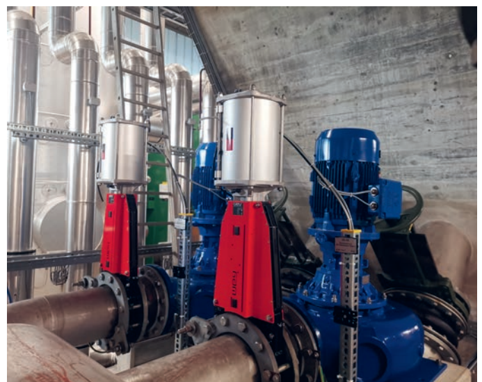
Pumpen und Schieber wurden im laufenden Betrieb nacheinander ersetzt.
