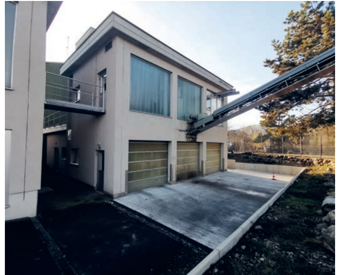
Der neue Vorplatz hat das richtige Gefälle und eine korrekte Platzentwässerung.
