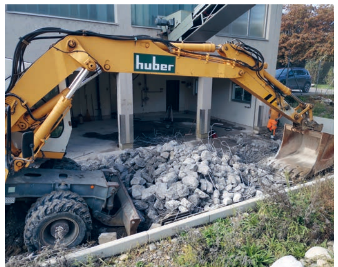
Mit schwerem Gerät wird die 80 cm dicke Betonplatte zerkleinert und abtransportiert.
