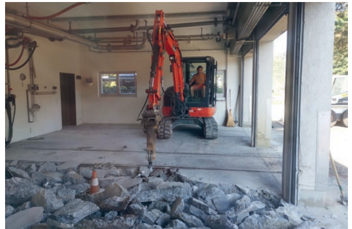
Die Bodenplatte im Gebäude wird rückgebaut.
