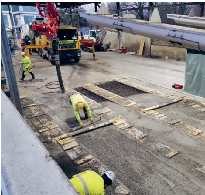
Jeweils zwei und zwei Fundamente werden gleichzeitig gegossen.
