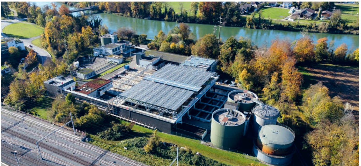
Die instandgesetzte Fassade fügt sich dezent ins Ortsbild ein.
