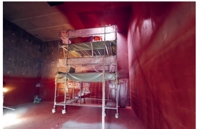
... sowie an den Wänden und der Decke aufgetragen.
