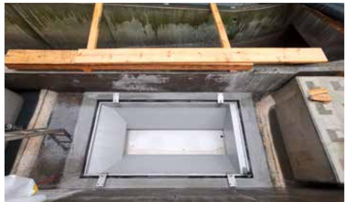
Die Chromstahlwanne samt Belüftung wird exakt positioniert und befestigt.
