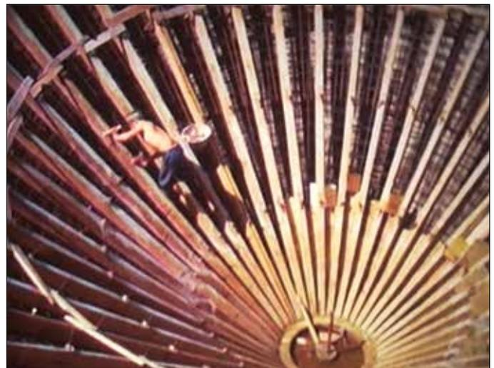
Zimmermannsarbeit für die Verschalungen beim Bau des ersten Faulturms
