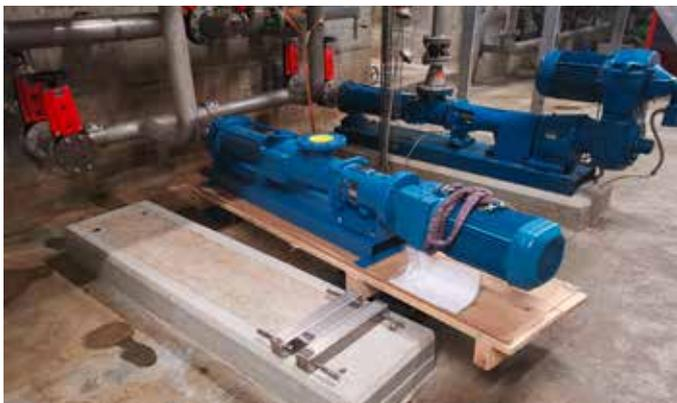
Das Fundament für die neue Pumpe ist vorbereitet. Redundanz ist für die Verfügbarkeit während der Instandhaltung und der Erneuerung unerlässlich.
