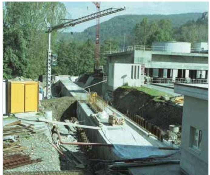
Bau des Leitungskanals zum neu erstellten Schlammsilo (1987)
