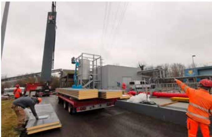
Die Kranarbeiten werden von Fachleuten der Axpo genauestens kontrolliert. Das Arbeiten unter der 110-Kilovolt-Leitung erfordert höchste Vorsicht.
