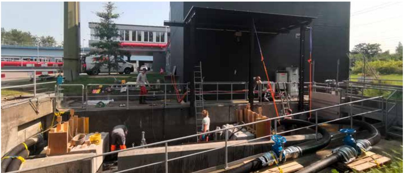
Trockenlegung des Zulaufkanals und Inbetriebnahme Pumpenprovisorium.
