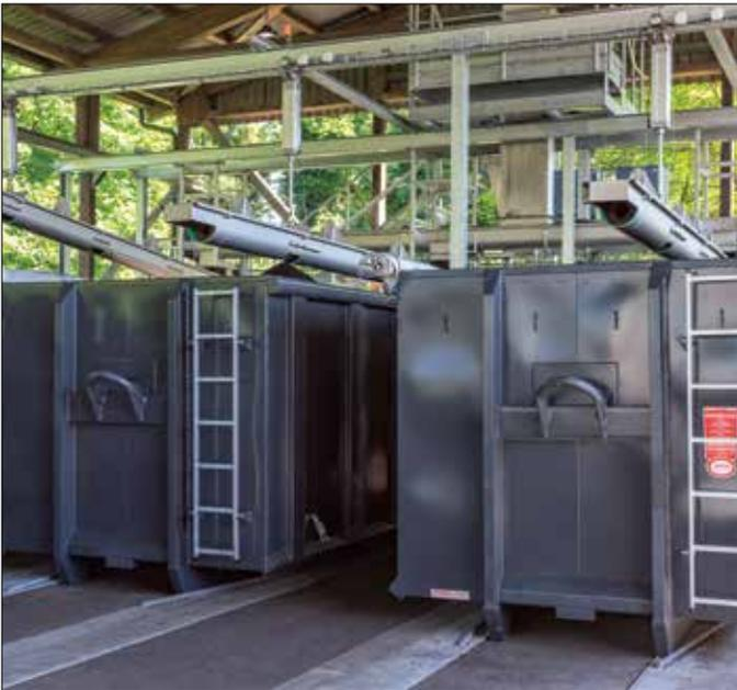
Der entwässerte Klärschlamm wird in Containern gelagert bis er der thermischen Verwertung zugeführt wird. (2021)
