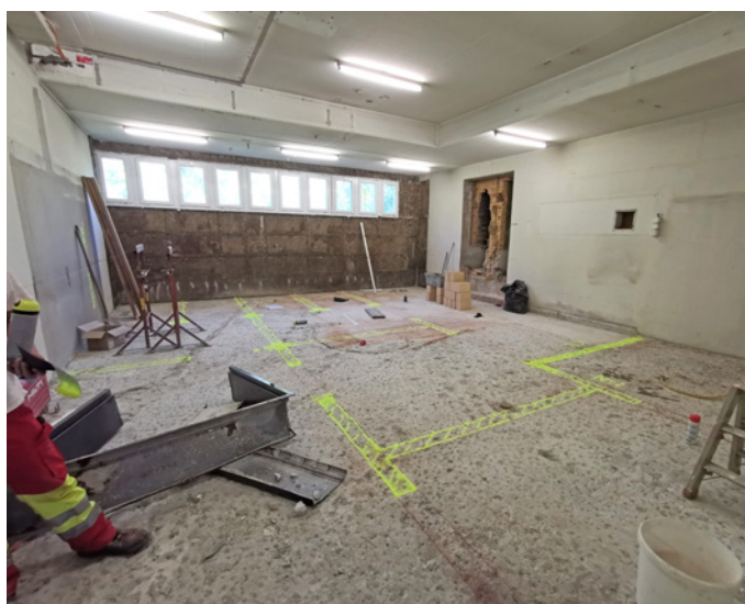
Die alte Heizzentrale wurde vom Team in Eigenleistung rückgebaut und recycelt. Es entsteht Platz für das neue Raumkonzept der Garderoben.
