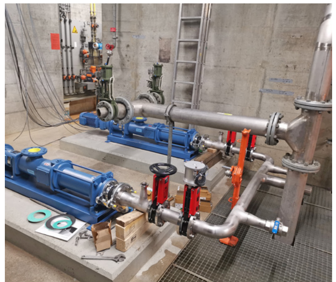
Die Rohrleitungen werden vor Ort neu erstellt oder angepasst.
