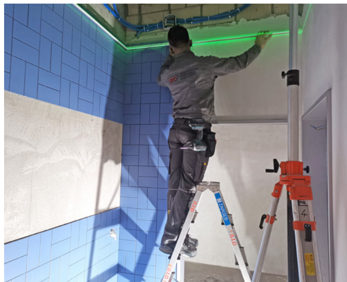
Die Plattenleger und die Deckenbauer arbeiten mit höchster Präzision.
