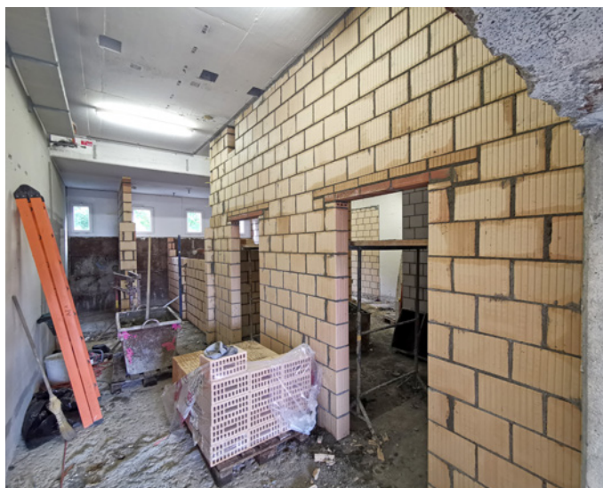
Die Mauern lassen erahnen, wo künftig die Umkleidekabinen und die Sanitäranlagen eingebaut werden.
