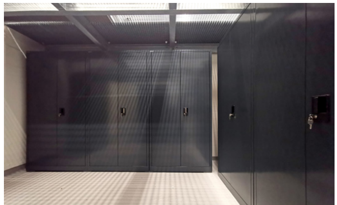
Im Untergeschoss entsteht das Archiv.
