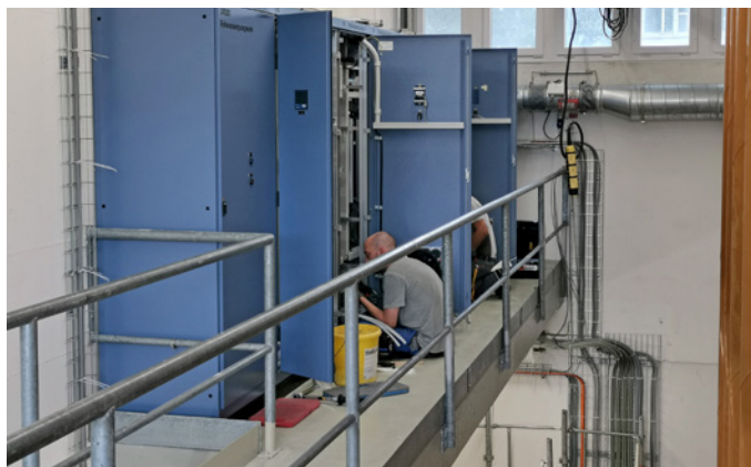
Die ARA-Betriebselektriker werden durch externe Elektromonteur unterstützt, um die Umbauzeit so kurz wie möglich zu halten.
