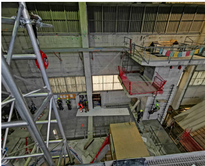
Ein ausgedientes Industrieareal bietet optimale Verhältnisse für die Ausbildung zum Arbeiten in Höhen und Tiefen.
