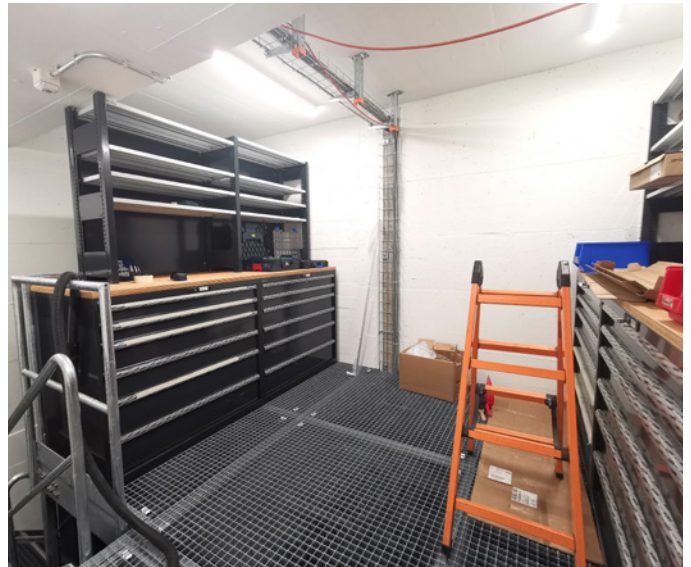
Auf dem oberen Stock wird das neue Elektro-Magazin eingerichtet.
