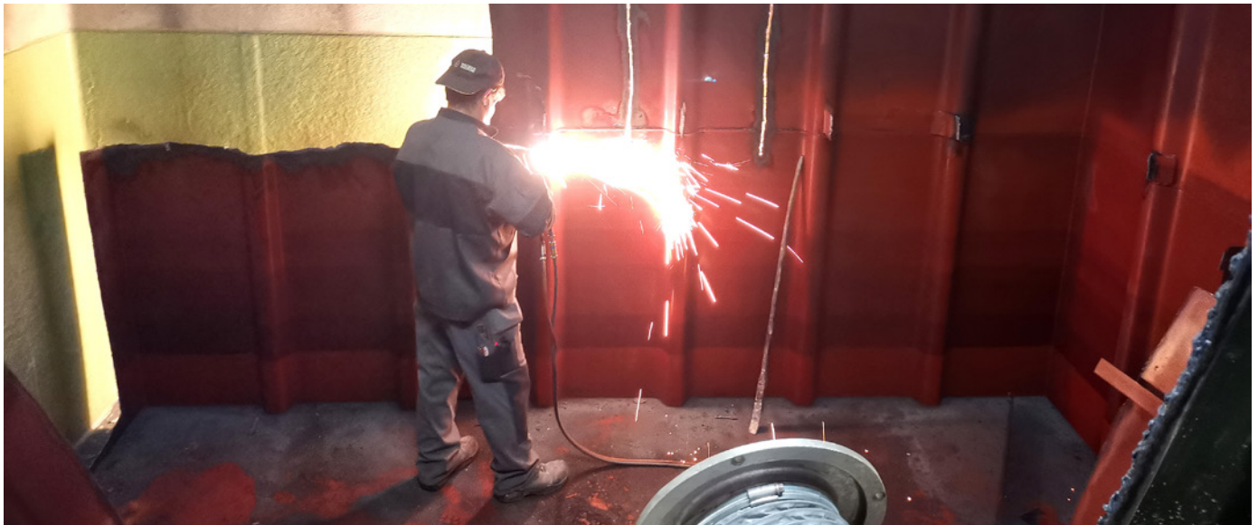
Da nur noch mit erneuerbarer Energie geheizt wird, kann der Öltank rückgebaut werden.
