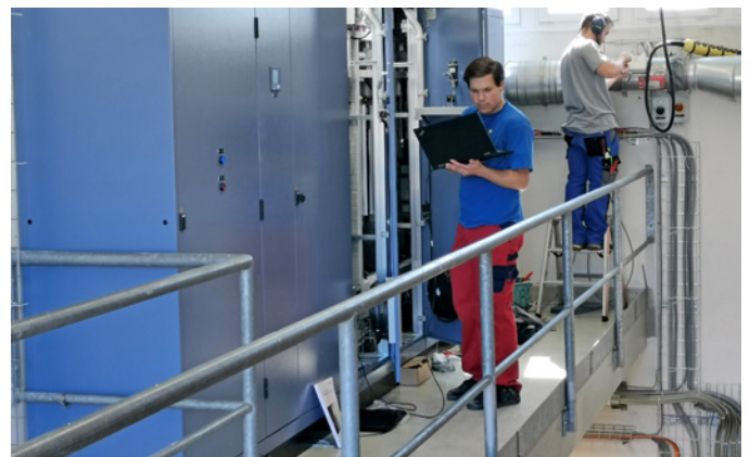
Für die Inbetriebnahme programmiert der Ingenieur die Frequenzumformer.
