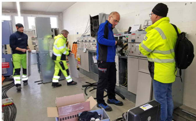
Der Umbau muss schnell gehen, die ARA läuft im Inselbetrieb.
