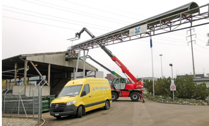
Die bestehenden Förderbänder werden komplett instand gestellt.
