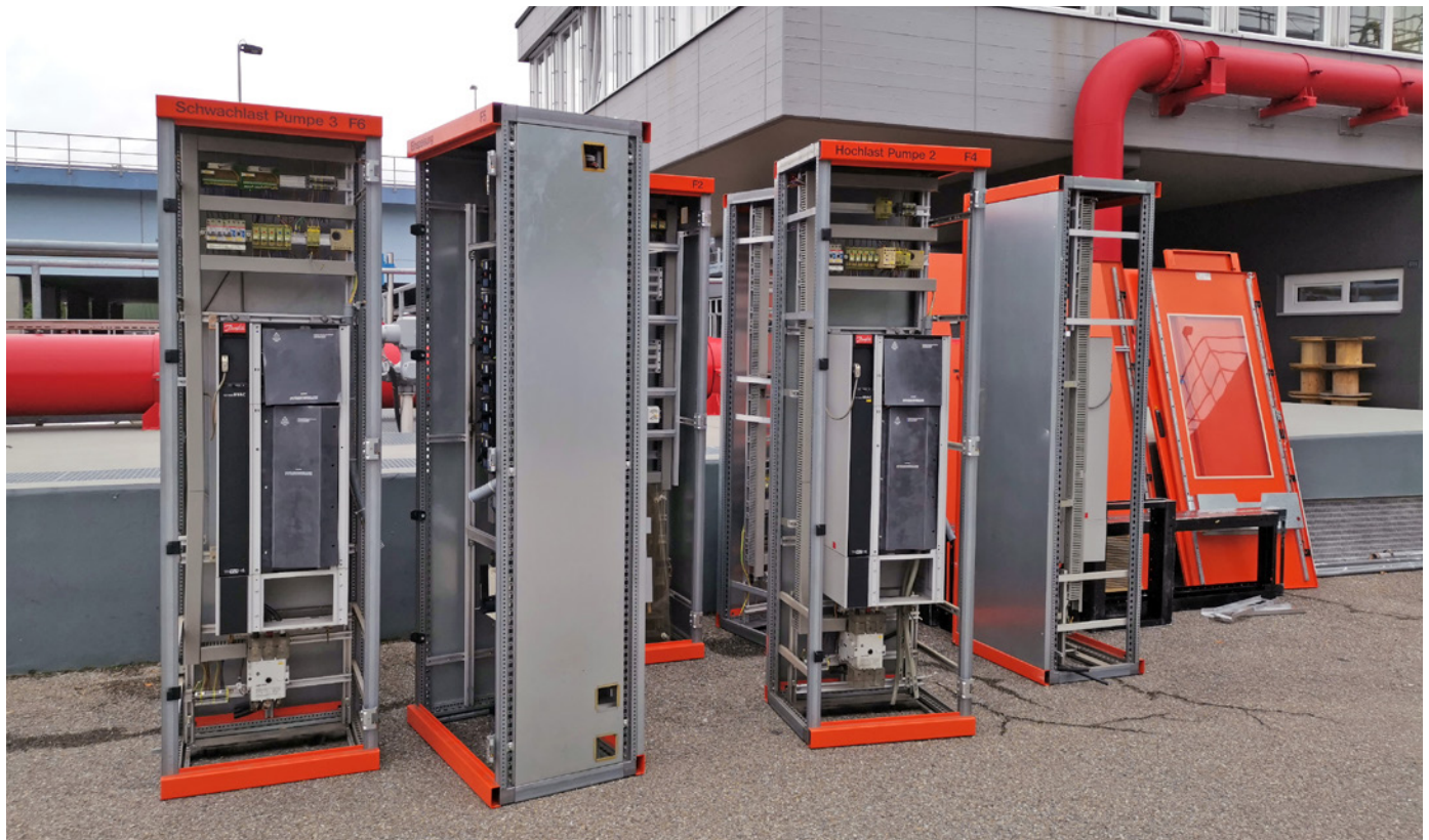
Die alten Schaltschränke werden abgebaut.
