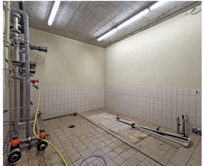
Die alte Polymerlösestation wurde in Eigenleistung rückgebaut.
