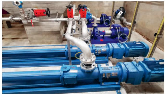
Im Hintergrund die neue Brauchwasseranlage, vorne zwei neue Frischschlammumpfen.
