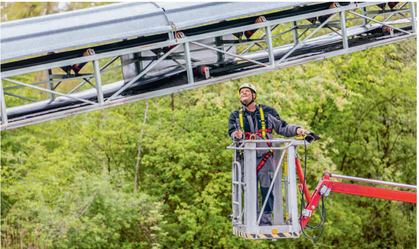
Inspektion: Vorbereitung für die anstehenden Instandhaltungsarbeiten an der Schlammförderanlage.
