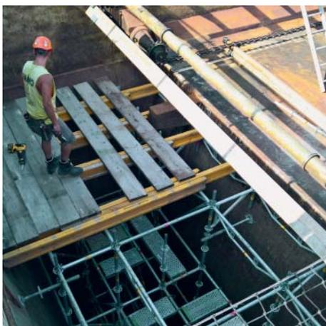
Konstruktion zur Abdeckung der Schlammtrichter
