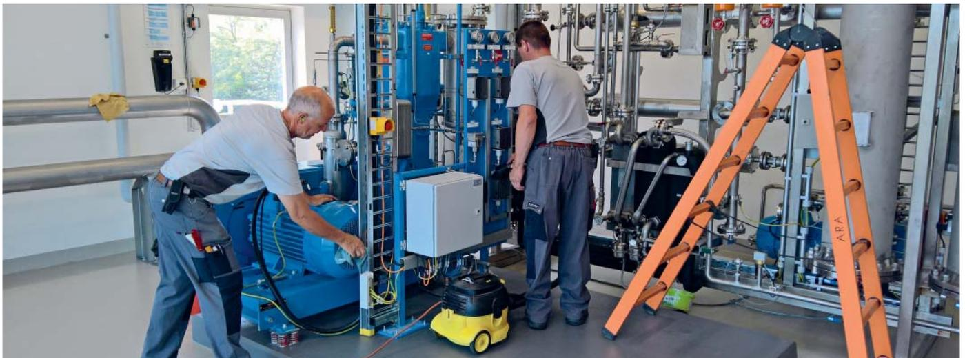
Letzte Handgriffe: Fachleute bereiten die Inbetriebnahme der Biogas-Aufbereitungsanlage vor.
